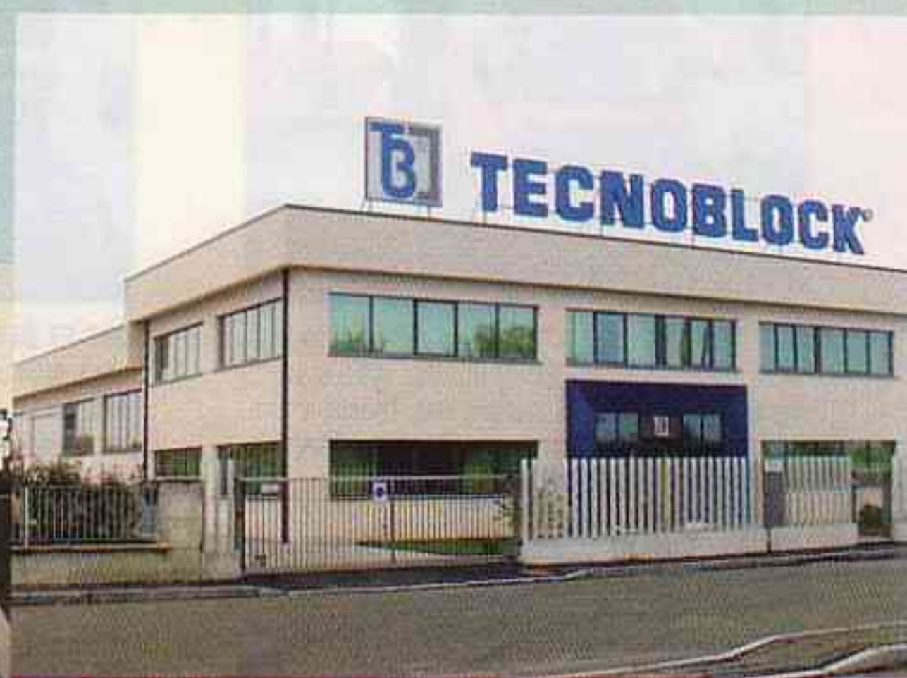
Sídlo firmy Tecnoblock v Piacenze
